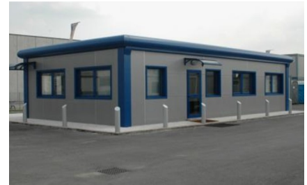
Aplicación especial a pedido en 1 nivel
