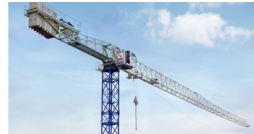
Grúas TIPO TORRE
